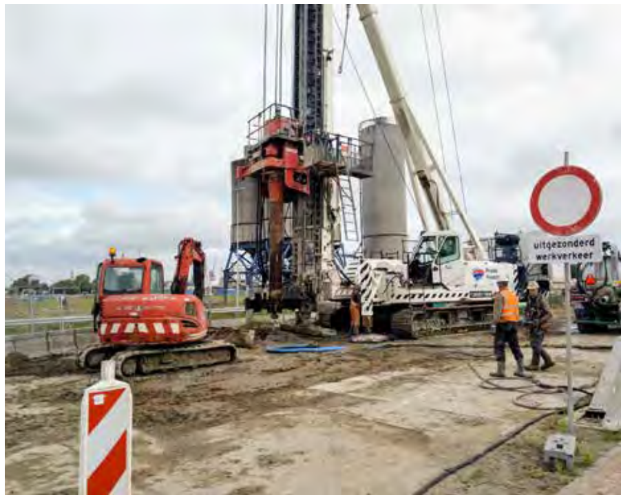
De installatie wordt klaargemaakt voor een volgende boorsessie.
